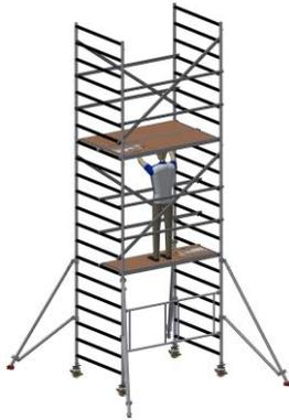
11. Geländerrahmen (*oberste Rahmeneinheit*) aufstecken. Dritten Durchstiegsbelag auf der nächsten Ebene einhängen.
