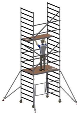
9. Sitzend vom Durchstiegsbelag aus die Horizontalen und Diagonalen an der anderen Außenseite montieren.
